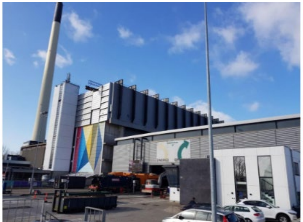
Figur 12-1 Eksisterende forhold set fra de indre dele af Vestforbrænding. På billedet ses modtagehal, vejebod, ovnhaller, trappetårn og skorsten.
